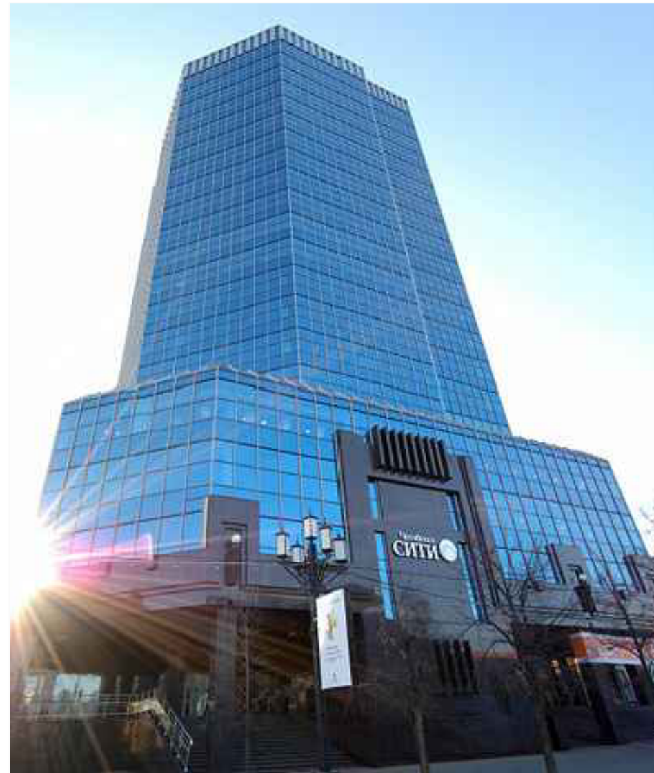
Офисное здание ( фото, 2014 г.)
